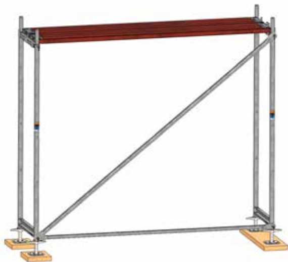
Bild 16: Fertig montiertes erstes Gerüstfeld
