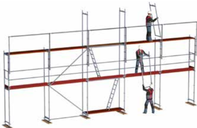
Bild 30: Montage der Gerüstlage im Schutze des MSG.
