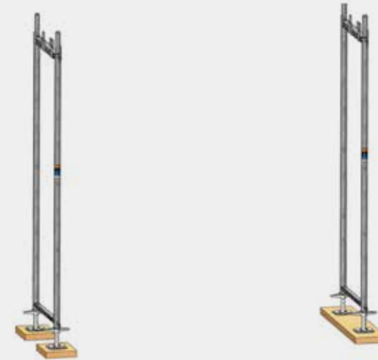
Bild 6: Aufbau des ersten Gerüstfeldes: Vertikalrahmen
