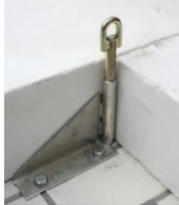
1) Der Permanentanker wird in Durchsteckmontage an der Wand angebracht und mit Dämmmaterial umbaut; die Augenschraube M16 ist ausspindelbar für 15 - 25 cm Wandaufbau.
